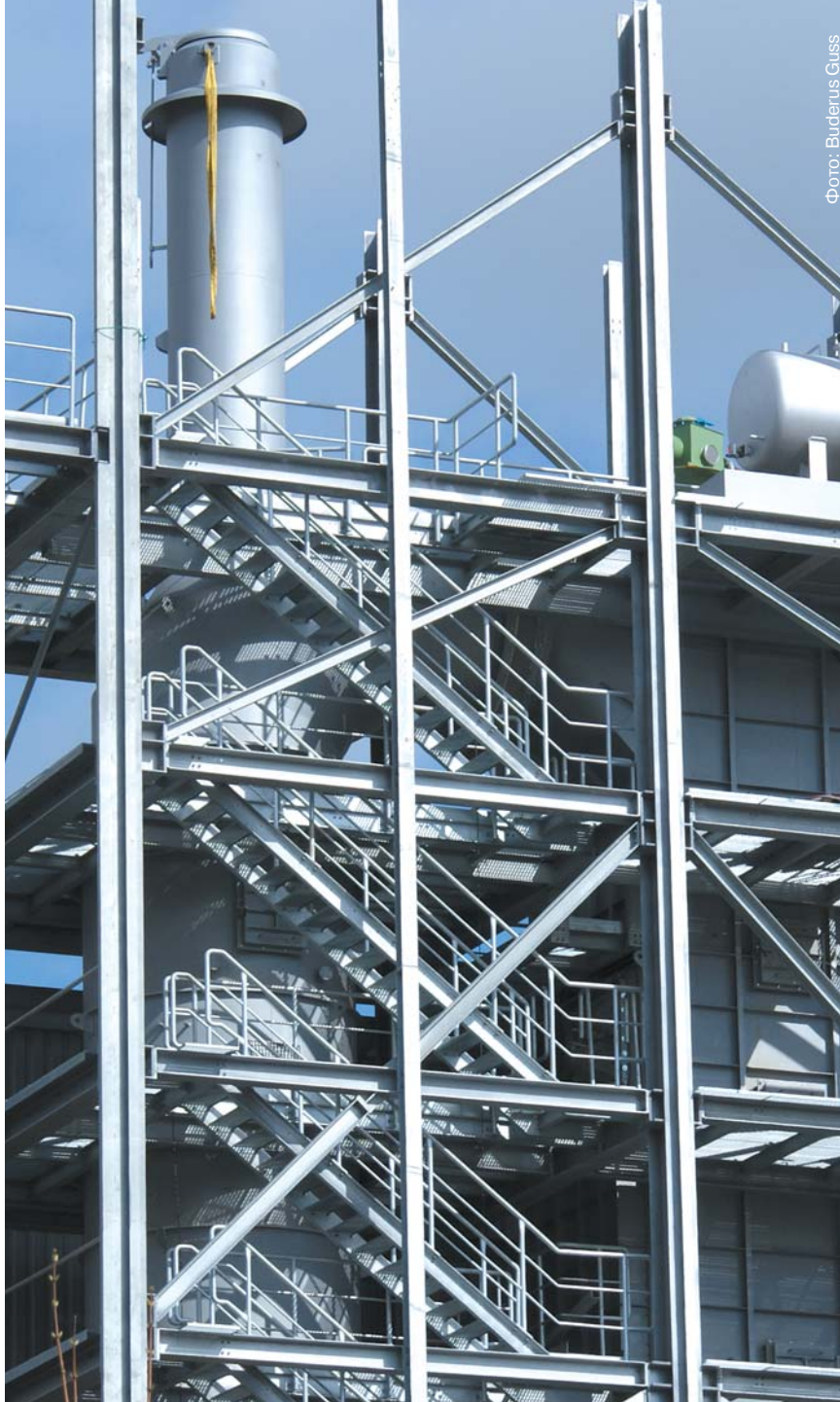
Сооружение установки для сухой пылеочистки газов, отходящих из вагранки
