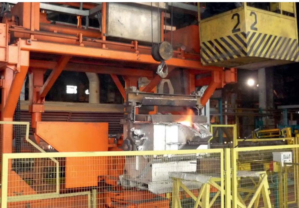
Рисунок 3. Новый заливочный автомат компании HWS в действии; заливочный автомат перемещается по подвесному рельсовому пути
