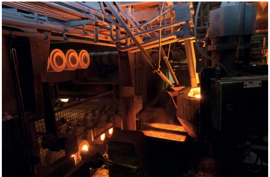
Участок центробежного литья труб: здесь производят трубы с номинальным диаметром 50–150 мм
