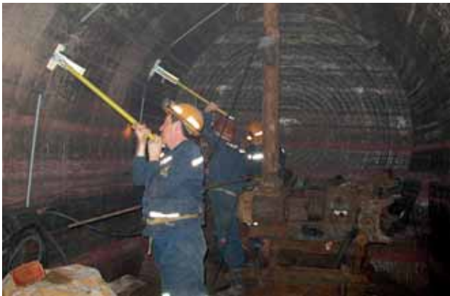
Рис. 1. Георадарная съемка методом продольного профилирования по стенкам горной выработки с применением георадара «Грот-12»
