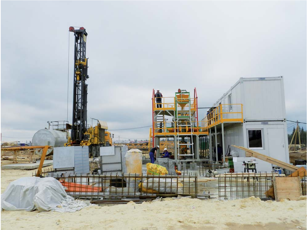
Экспериментально-лабораторный комплекс на стадии строительства
