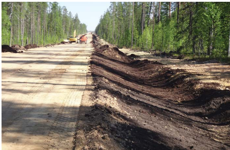
Подъездная дорога к месторождению им. В. Гриба
