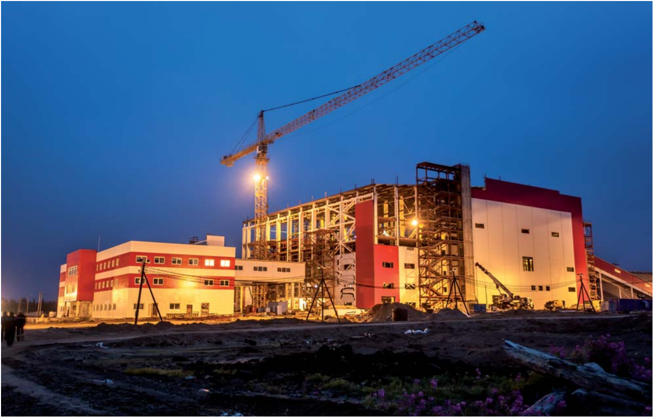
Строительство обогатительной фабрики
