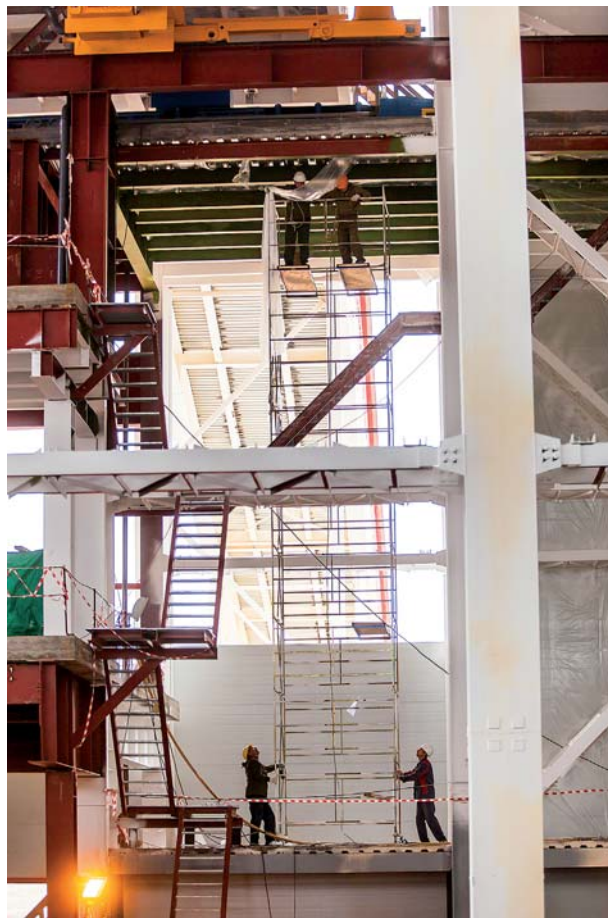
Строительно-монтажные работы в главном корпусе обогатительной фабрики
