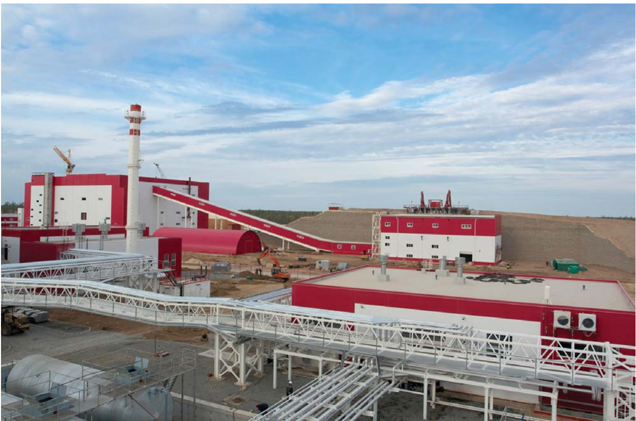
Общий вид обогатительной фабрики
