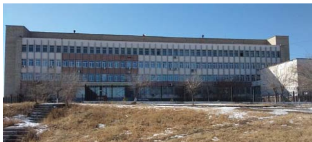
Здание филиала № 3 в г. Краснокаменске
