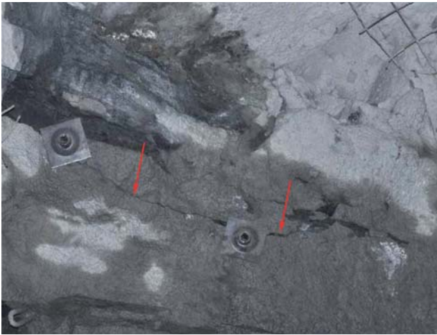
Рис. 4. Образование трещин при установке анкеров параллельно слоистости
