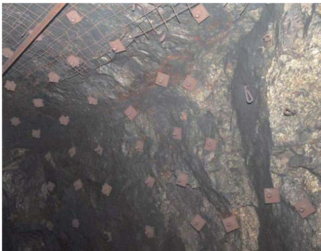
Рис. 3. Крепление выработки анкерной крепью Swellex
