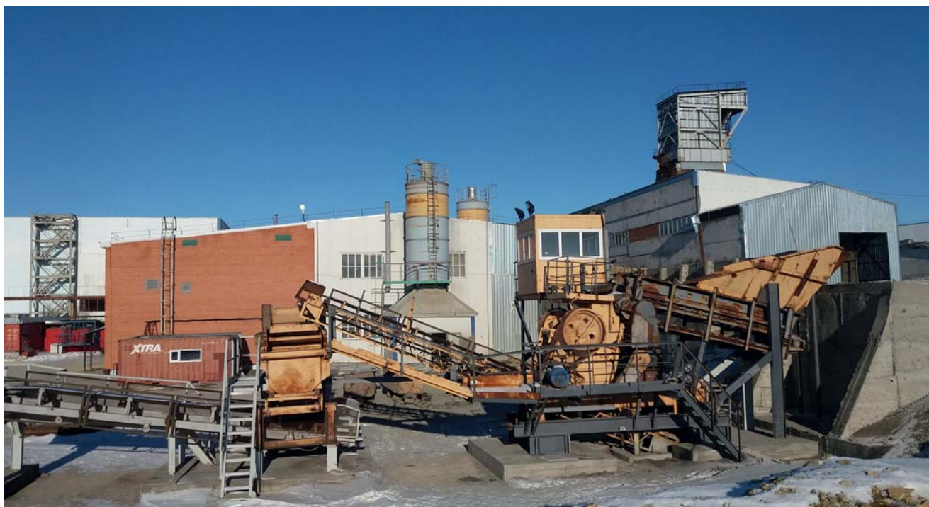
Рис. 4. Бетонозакладочный комплекс месторождения Первомайское
