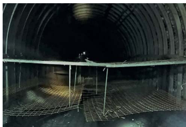
Рис. 2. Армирование искусственного перекрытия
