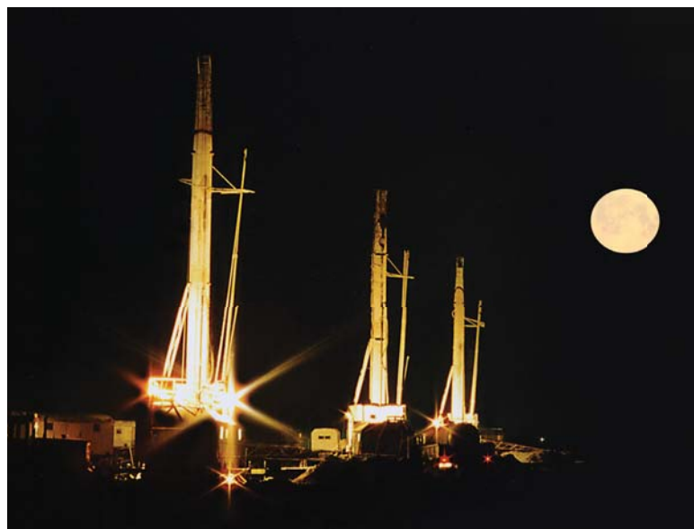
Буровые работы на Далматовском месторождении
