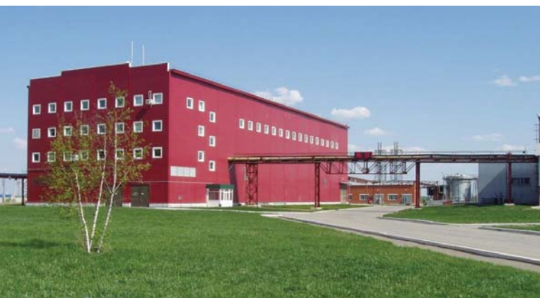
Рис. 3. Здание главного технологического корпуса
