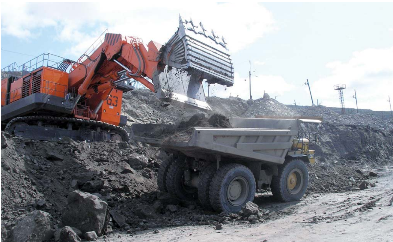
Проходка съезда гидравлическим экскаватором Hitachi EX 3600T-6
