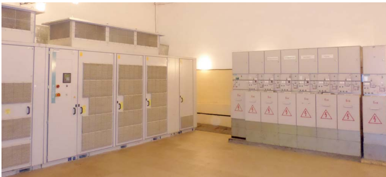
Система группового запуска землесосов с применением частотных преобразователей
