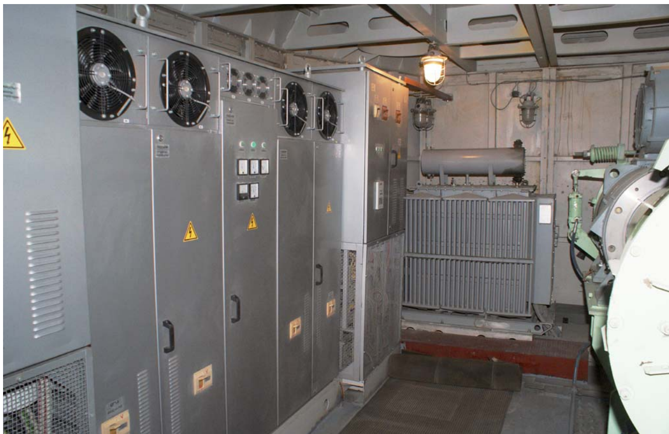
Низковольтное комплектное устройство серии КЭР-12 для управления приводами экскаваторов по системе «тиристорный преобразователь — двигатель»
