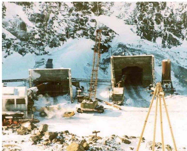
Строительство вскрывающих автотранспортного и конвейерного уклонов с отм. +180 м карьера рудника «Заполярный»
