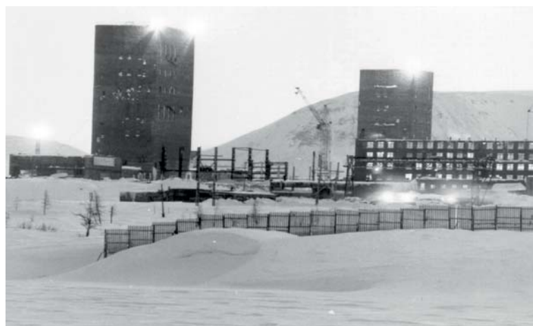
Строительство объектов рудника производилось круглый год, несмотря на сложные климатические условия
