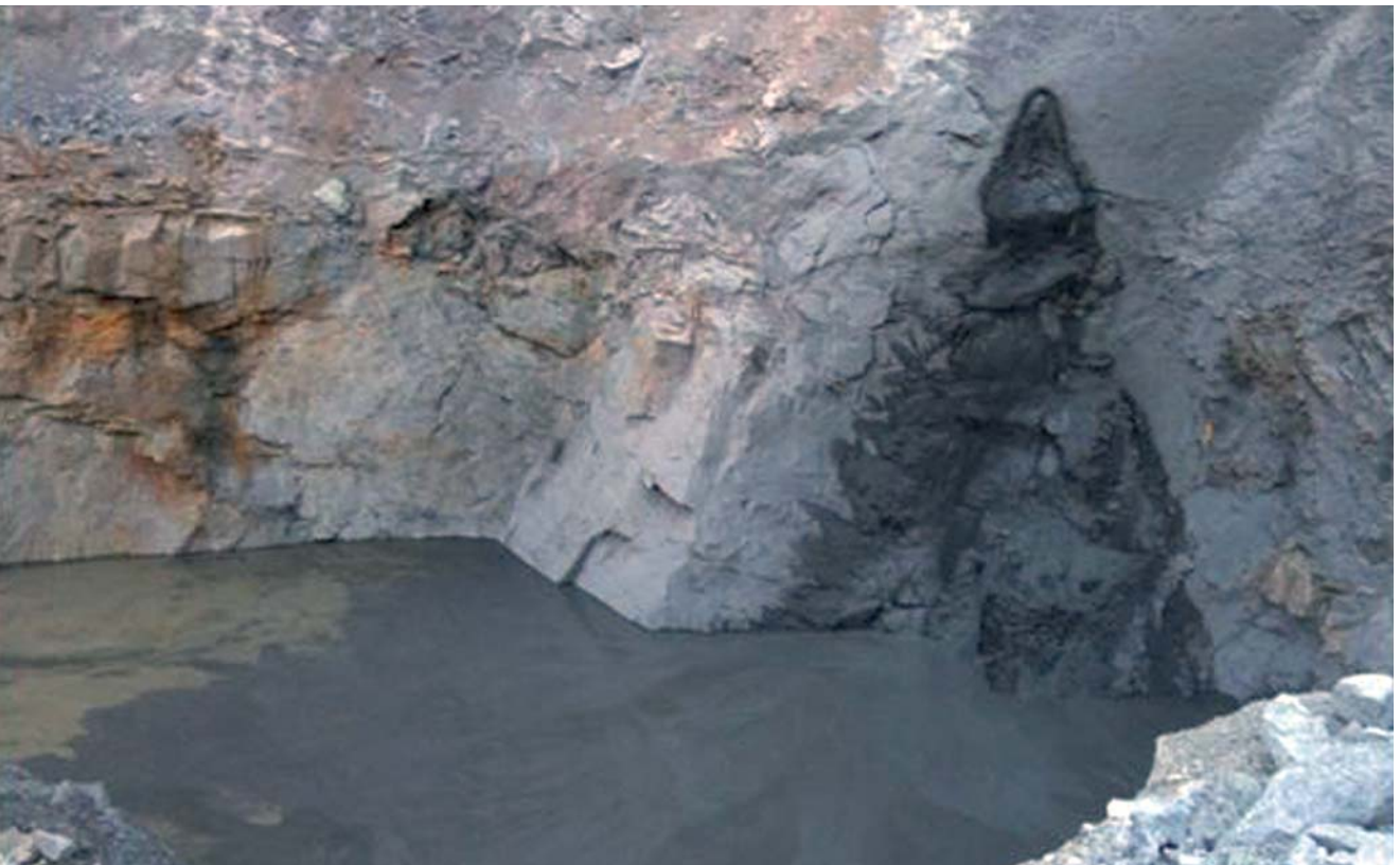
Закладка выработанного пространства камеры твердеющей смесью
