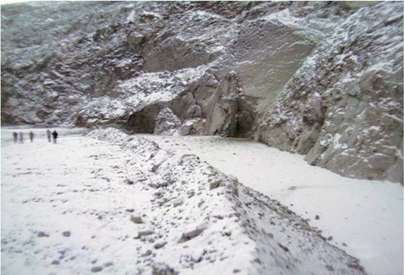
Комбинированный искусственный предохранительный целик на участке восточного борта карьера
