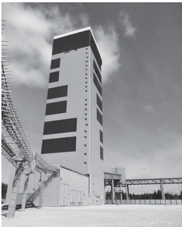
Рис. 1. Башенный копер скипоклетевого ствола шахты «Черемуховская-Глубокая» ОАО СУБР
