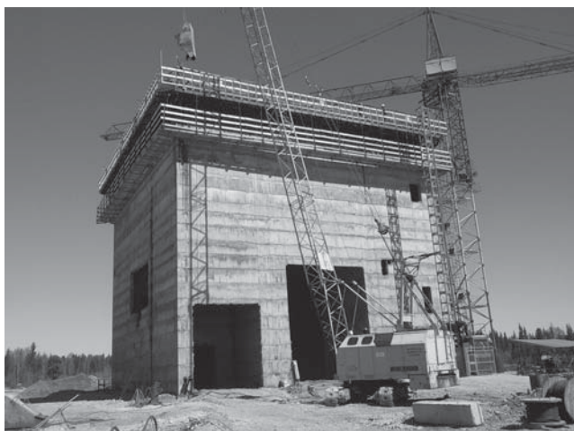
Рис. 1. Строительство копра СКС с использованием скользящей опалубки
