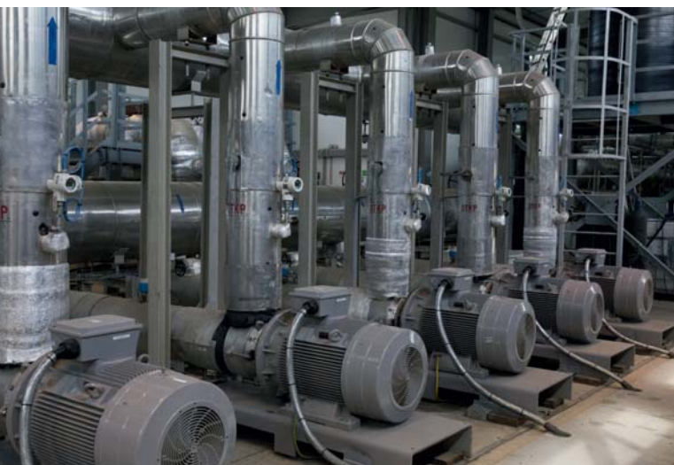
Насосы циркуляции хладоносителя
