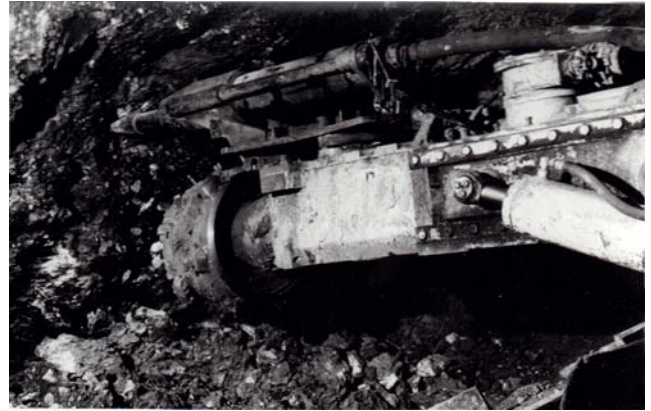
Рис. 2. Разрушение средней части забоя исполнительным органом ударного действия
