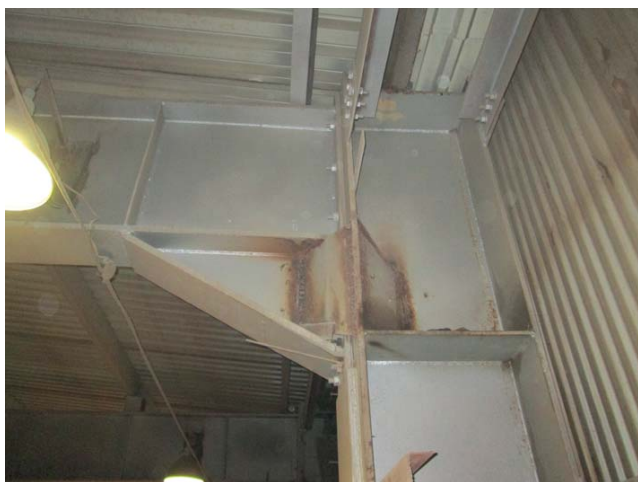
Рис. 2. Фактический (усиленный) узел сопряжения ригелей с колоннами
