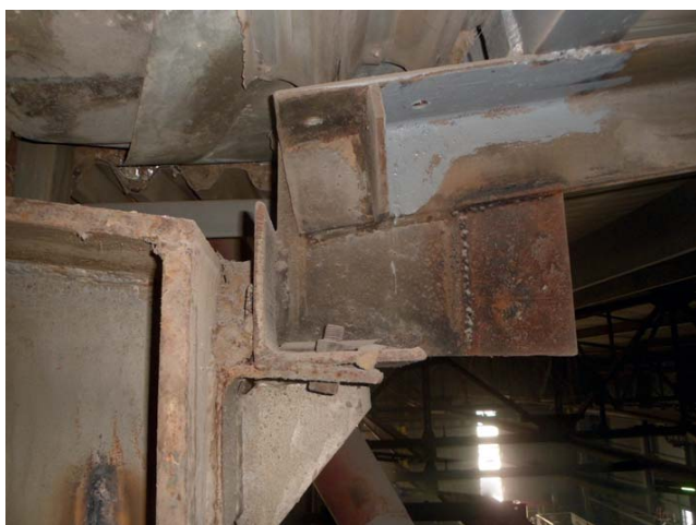
Рис. 3. Фактическое (шарнирное) сопряжение верхнего пояса стропильной фермы с колонной (по проекту жесткое, с использованием «рыбки»)
