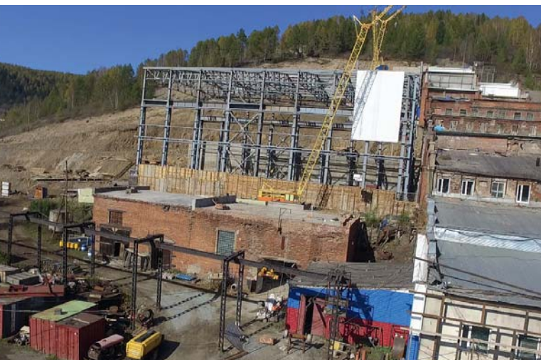
Рис. 1. Строительство золотоизвлекательной фабрики
