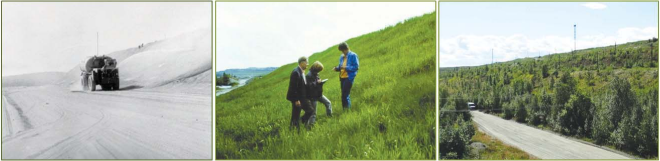
Рис. 2. Формирование фитоценоза со структурой окружающего природного ландшафта в ходе сукцессии сеяного без нанесения плодородного слоя злакового фитоценоза. Ограждающая дамба складированных отходов рудообогащения (действующее хвостохранилище)
