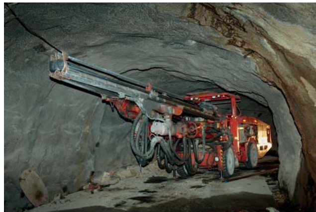
Буровая установка для бурения шпуров в забоях горно-подготовительных и нарезных выработок
