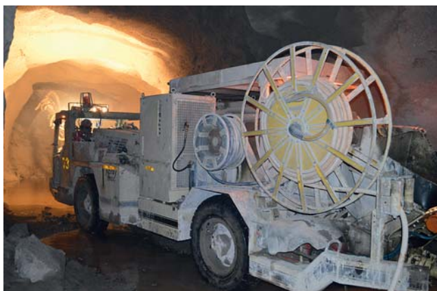
Рис. 2. Крепление горной выработки набрызг-бетоном с добавками фирмы BASF «под забой» (в зоне взрывных работ)
