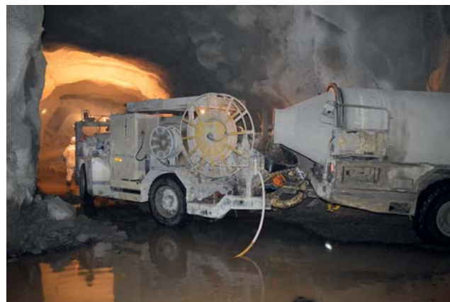
Рис. 1. Возведение набрызг-бетонной крепи с применением машины Spragmet 1050 WPC фирмы Normet и миксера готового раствора
