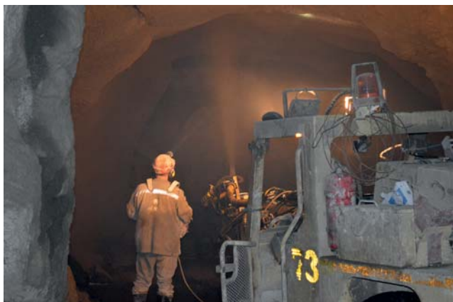
Рис. 1. Возведение набрызг-бетонной крепи с применением машины Spragmet 1050 WPC фирмы Normet и миксера готового раствора
