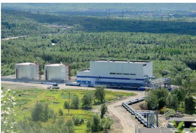
Центральный тепловой пункт в г. Кировске
