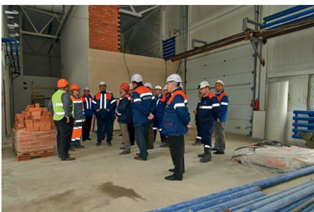
На строительстве завода по выпуску ЗВВ
