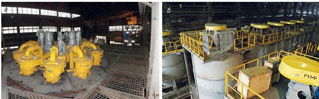
**Монтаж насосно-гидроциклонных установок в цикле измельчения руды (а) и флотационного оборудования в главном корпусе НОФ (б)**
