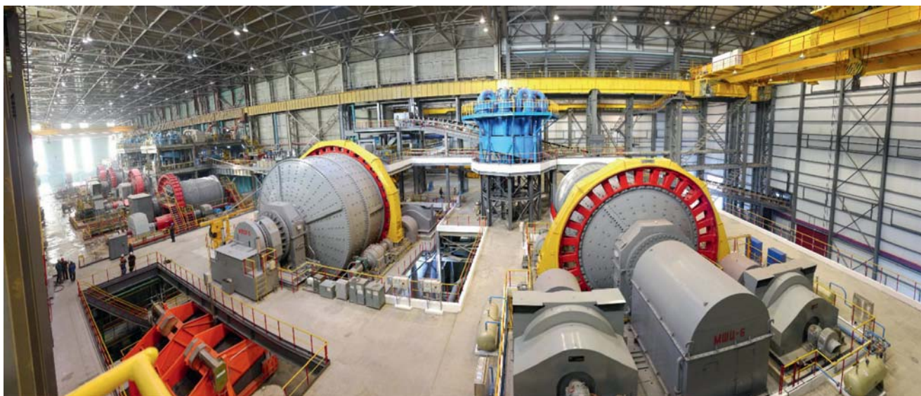
Рис. 4. Секция КСИ-3 перед вводом в эксплуатацию
