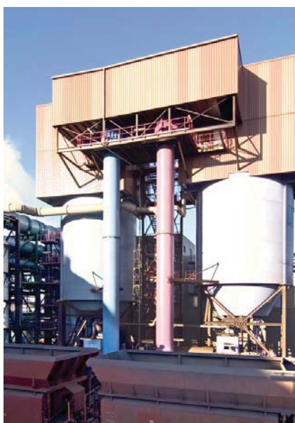
Рис. 3. Возврат мелких фракций шихты после грохочения в доменный процесс
