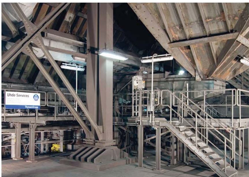
Рис. 2. Окно выдачи бункера и разгрузочное устройство линии подачи кокса
