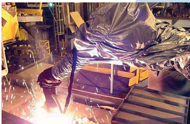
Рис. 5. Измерение температуры роботами LiquiRob на МНЛЗ № 3 компании Usiminas Cubatão
