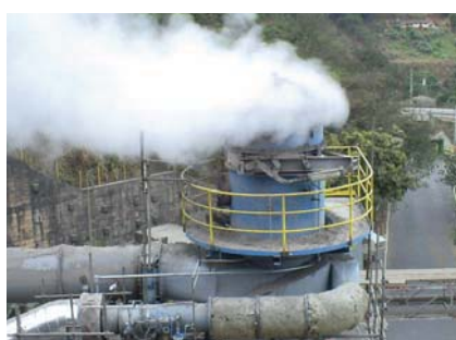
Рис. 2. Дымовая труба без обеспыливающего устройства
