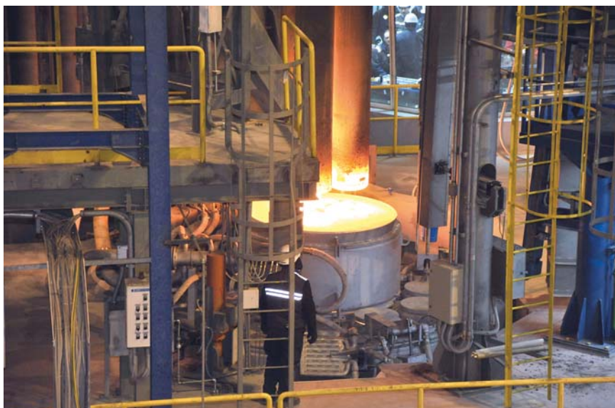
Рис. 3. Двухпозиционный агрегат ковш-печь
