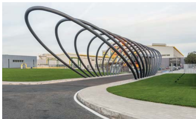
Рис. 11. Главный вход в комплекс Interpipe Steel
