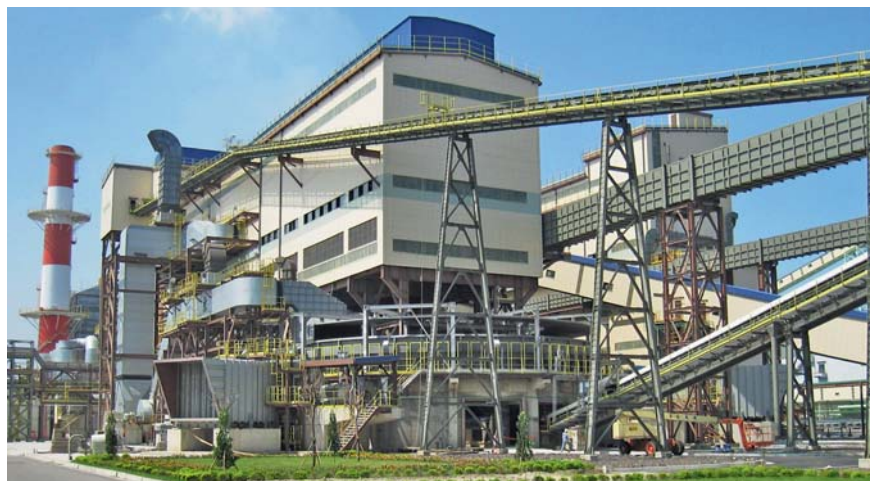
Рис. 2. Общий вид агломерационной фабрики № 1; на переднем плане — кольцевой участок охлаждения агломерата с погружным направляющим рельсом
