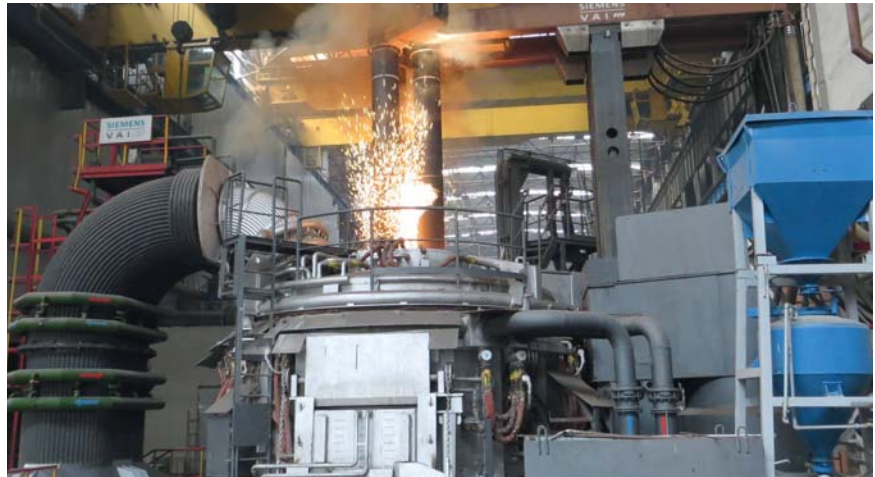
50-тонная электродуговая печь с удельным расходом электроэнергии 370 кВт·ч/т стали
