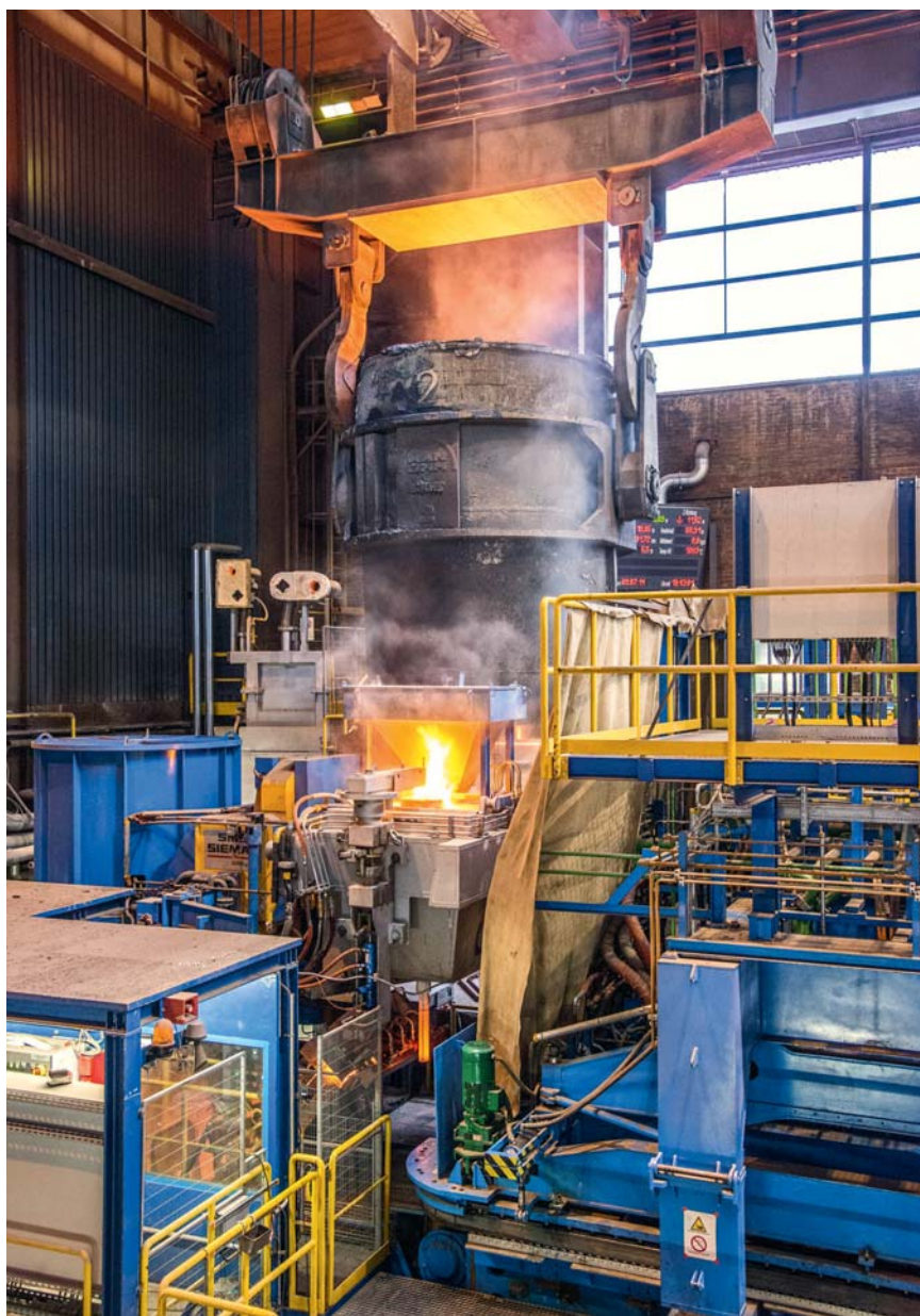
Разливка жидкой стали из разливочного в промежуточный ковш установки ленточного литья
