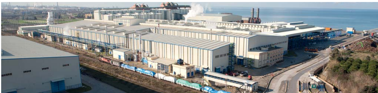
Рис. 1. Новый металлургический завод MMK Metalurji, расположенный на побережье Средиземного моря
