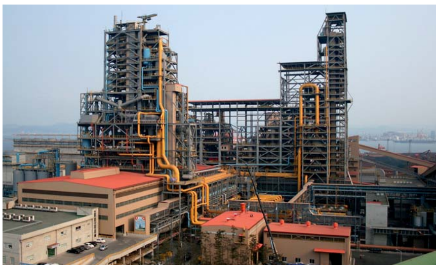
Рис. 1. Общий вид цеха с установкой Finex производительностью 1,5 млн. т/год на заводе в Пхохане, Южная Корея (слева — плавильный газификатор; справа — реактор с кипящим слоем)
