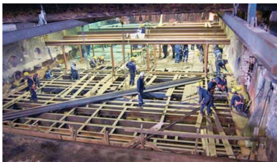
Предприятие компании Erdemir, Эрегли, Турция. Модернизация толкательной печи № 2 в линии стана горячей прокатки полосы № 2. Сооружение новой системы направляющих брусьев
