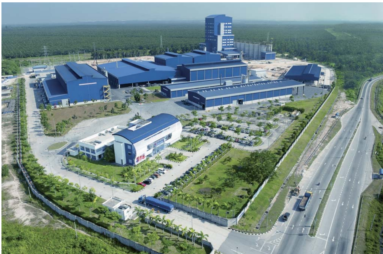
Общий вид нового завода Группы SGL в Бантинге, Малайзия, по производству графитированных электродов и катодов
