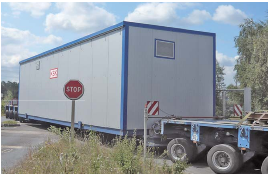
Доставка насосной станции
