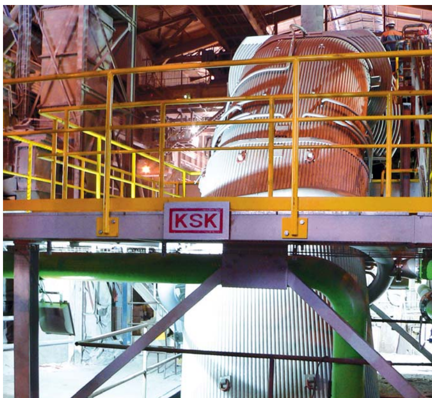
Патрубок газохода отходящих газов, присоединенный к ЭСП
