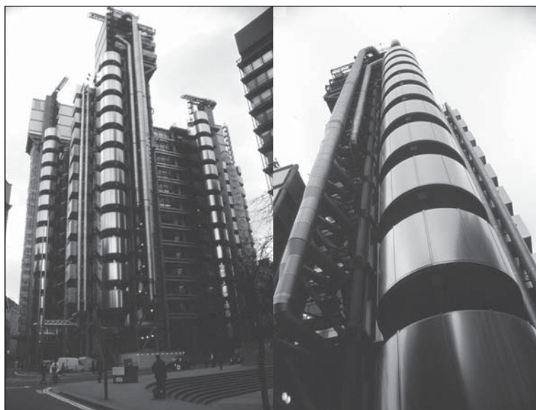
Рис. 2. Здание Lloyds of London. Металлическая конструкция разработана архитектурной компанией Gartner; внешние листы выполнены из коррозионностойкой стали марки 316S16 с тканевым рельефом для предотвращения отражения; ровные листы имеют выпуклое исполнение в лифтовой зоне, а в зоне лестничного пролета листы имеют плоскую поверхность благодаря предварительно напряженному состоянию
