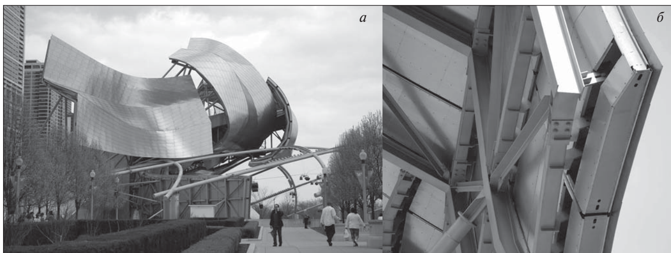
Рис. 3. Павильон Jay Pritzker, Чикаго, 2004 (парк Millennium). Небольшие по размеру пластинки из коррозионностойкой стали формируют поверхность произвольной формы (а), закрепленной на каркасе из основных и вспомогательных балок (б)
