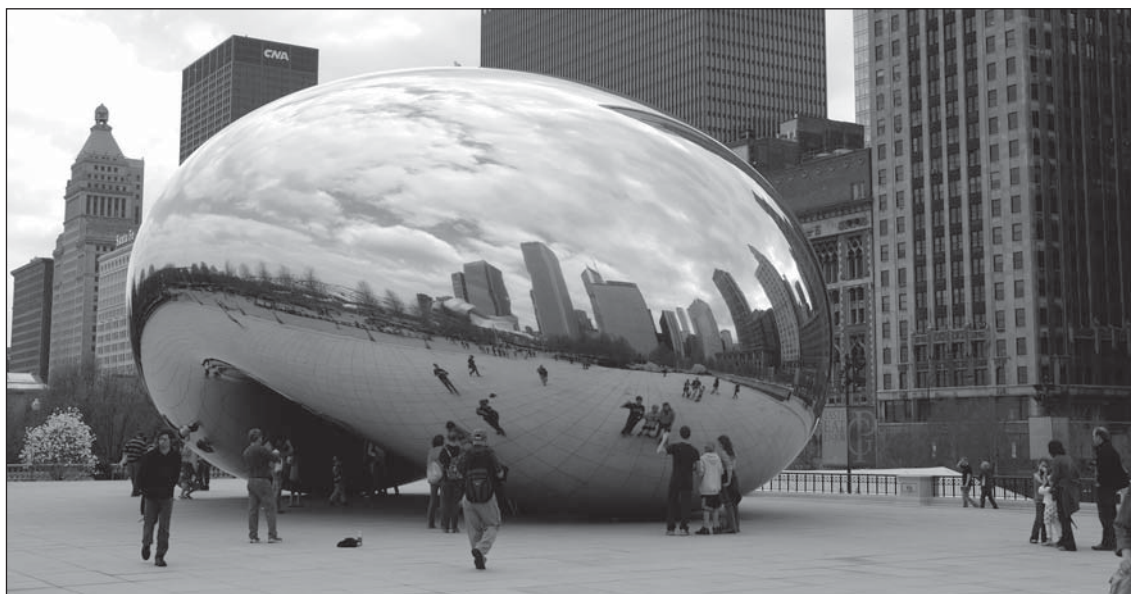
Рис. 1. Скульптура «Облачные ворота» (Cloud Gate), Чикаго, 2006. Внешняя оболочка состоит из 168 пластин из коррозионностойкой стали общей массой примерно 100 т
