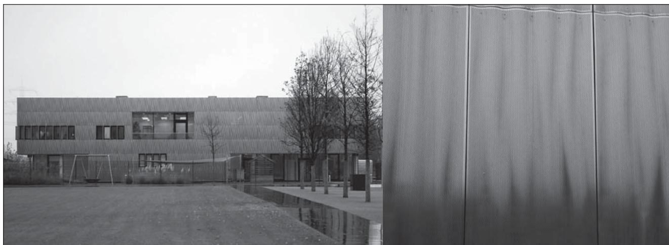
Рис. 13. Детский сад компании ThyssenKrupp Quartiers в Эссене: фасадные пластины из коррозионностойкой стали компании Fielitz, Ингольштадт, получены методом гидроформования. Пластины имеют волнистость и отверстия
