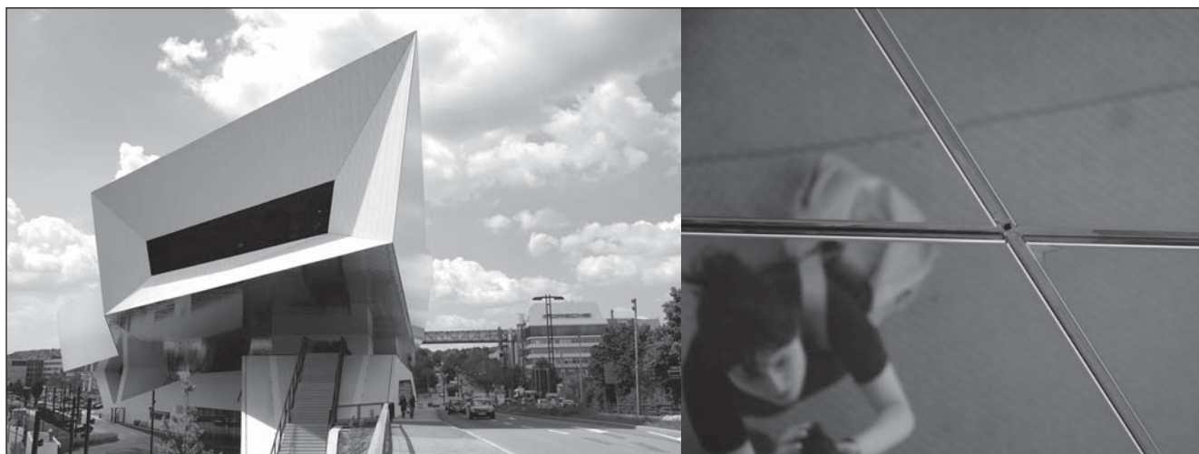
Рис. 4. Музей Porsche, Штутгарт, 2009. Справа: снимок нижней части с окантованными ромбами из коррозионностойкой стали в качестве подвешенной вентилируемой конструкции
