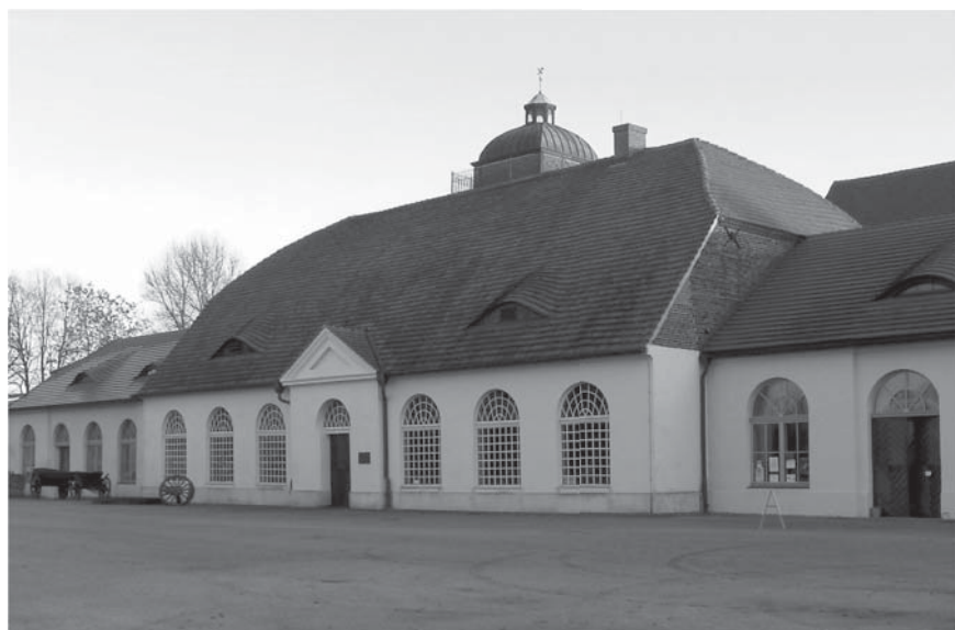
Металлургический завод в Пайце. Помещение литейного цеха под крышей из деревянных стропильных конструкций. В центре крыши видны купол и дымовая труба доменной печи, сооруженной в 1810 г.
