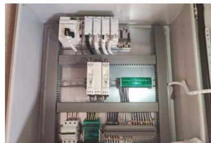
**Рис. 5.** Шкаф управления с ПЛК Schneider Electric Modicon 342020. Монтажная панель (вид спереди)
