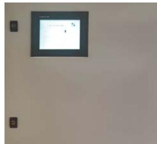
**Рис. 4.** Сенсорная панель оператора Magelis, установленная на дверцу шкафа управления
