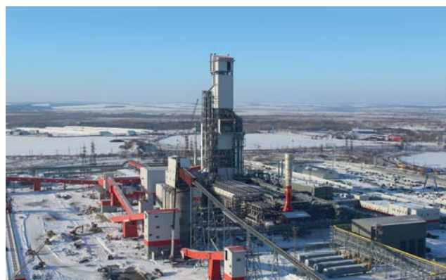
На строительстве ЦГБЖ-3
